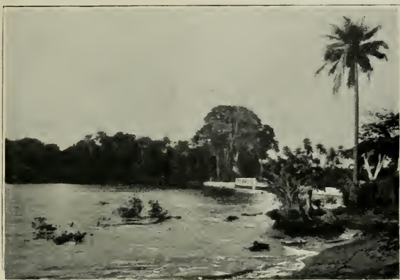
LE PONT DE TOUMBO RELIE KONAKRY A LA TERRE FERME.
